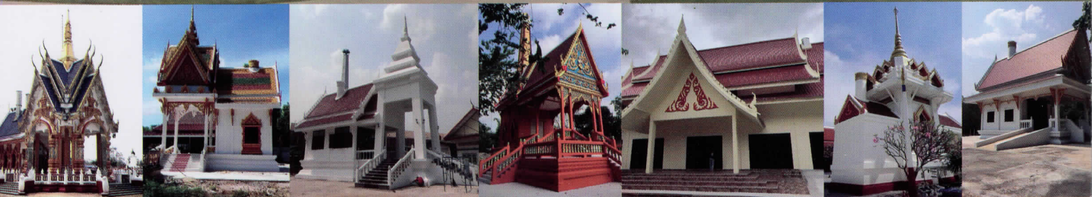
ผลงานก่อสร้างเมรุ พร้อมติดตั้งเตาเผาพปลอดมลพิษ
